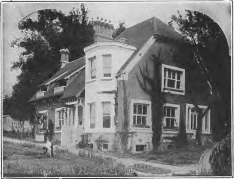
Verrières. — Le laboratoire de biologie et pathologie végétale et de génétique.
